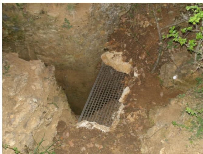
A trepni beépítése (Fotók: Szilaj Rezső, a képeken Harmat István)
