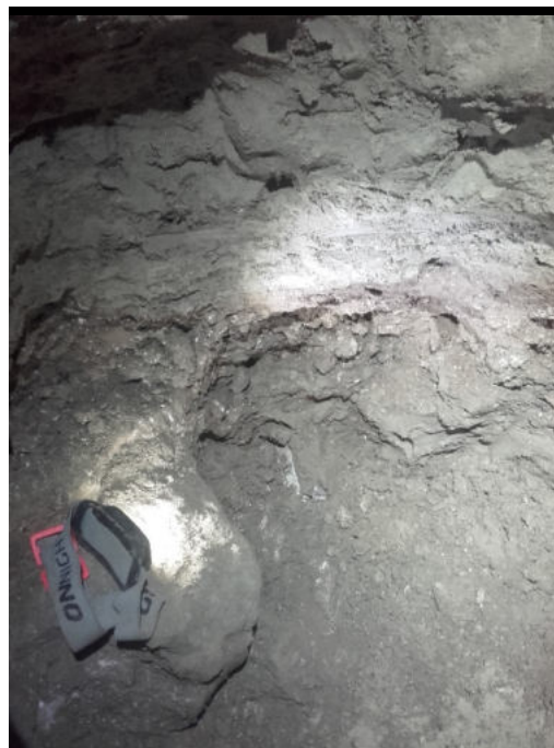
Rétegek az aknában (felül: talajbemosódás a főte alatt a homokon, alul: homok – agyagos réteg határ; köves-földes kitöltés az aljzaton az agyag alatt)
