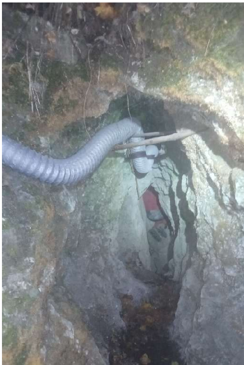
4. ábra Járattágítás, mobil szellőztetés
