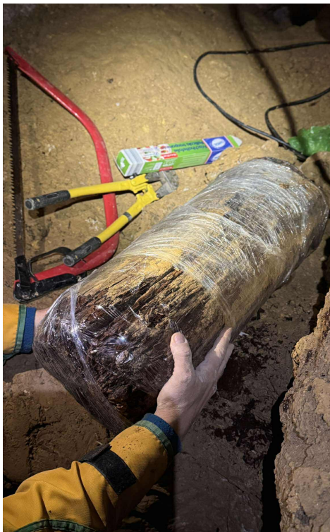
11. ábra Feldarabolt korhadtt fa gerendák szállításához való előkészítése
