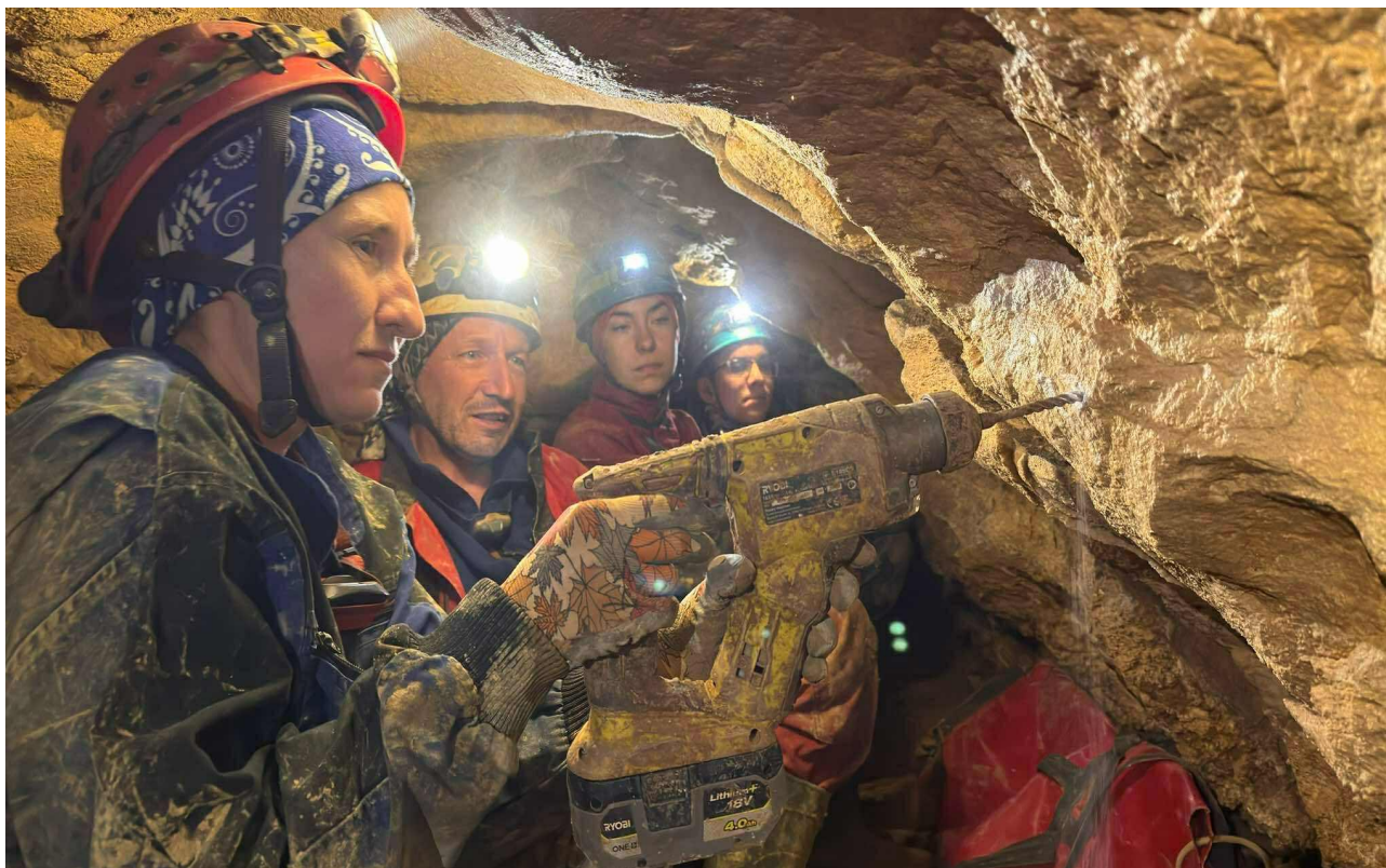
6. ábra A Kút kiépítése a Középfolyosó irányából
