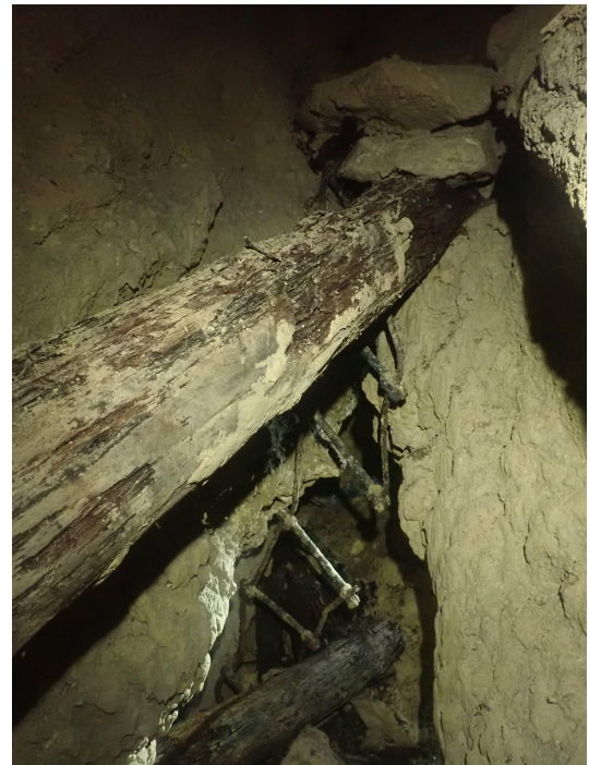
10. ábra Korhadtt fa gerendák és korrodált hágcsó a Kút alján
