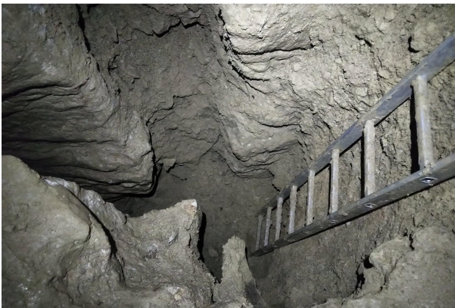
25. ábra A CSL-akna megsuvadt része a Keresztfolyosóból fotózva. Jól kivehető a szálkő hasadékkeresztezés.
